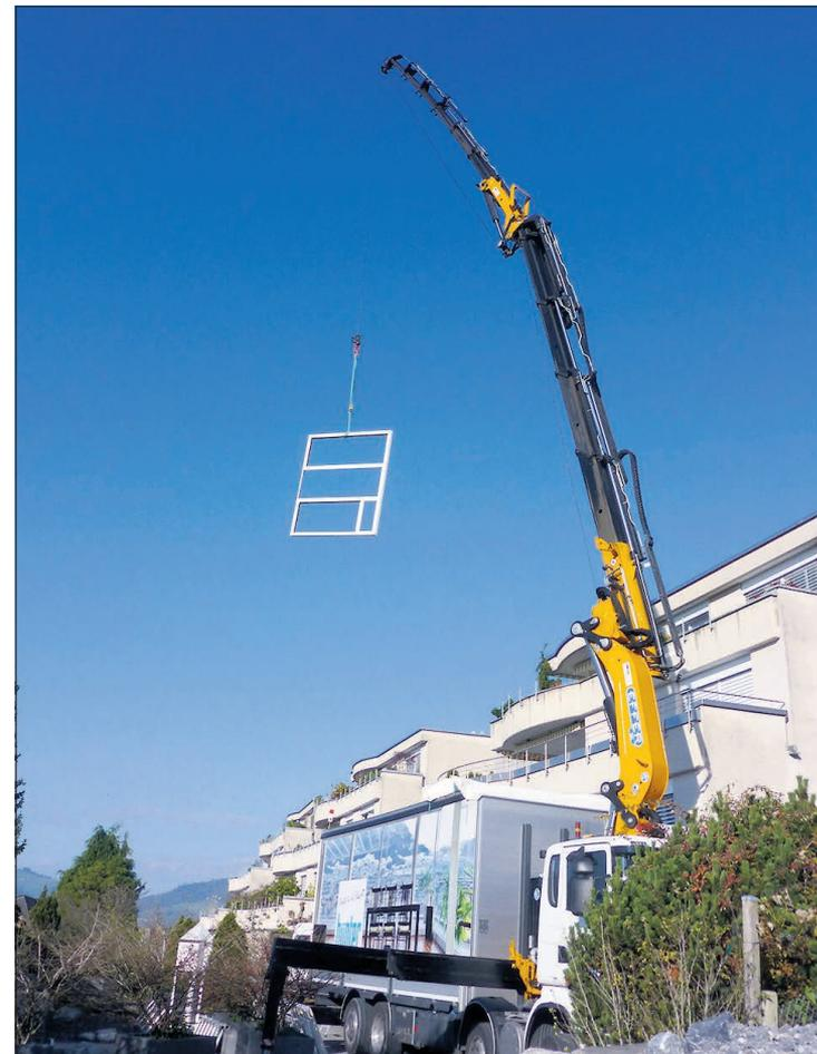
Immer mehr Wohnhäuser mit zum Teil grossen Fensterelementen benötigen Fenster und neue Verglasungen. Dies ist oft eine grosse Herausforderung, da nicht wie bei Neubauten Gerüste, Podeste und dergleichen zur Verfügung stehen. Die **FENSTER BÜNTER AG** hat diverse Hilfsmittel und Einrichtungen entwickelt, so dass auch bei solch schwierigen Einbausituationen, wo andere Fensterbauer passen müssen, Fenster und Verglasungen den Wünschen der Bauherrschaft entsprechend ersetzt werden können.
